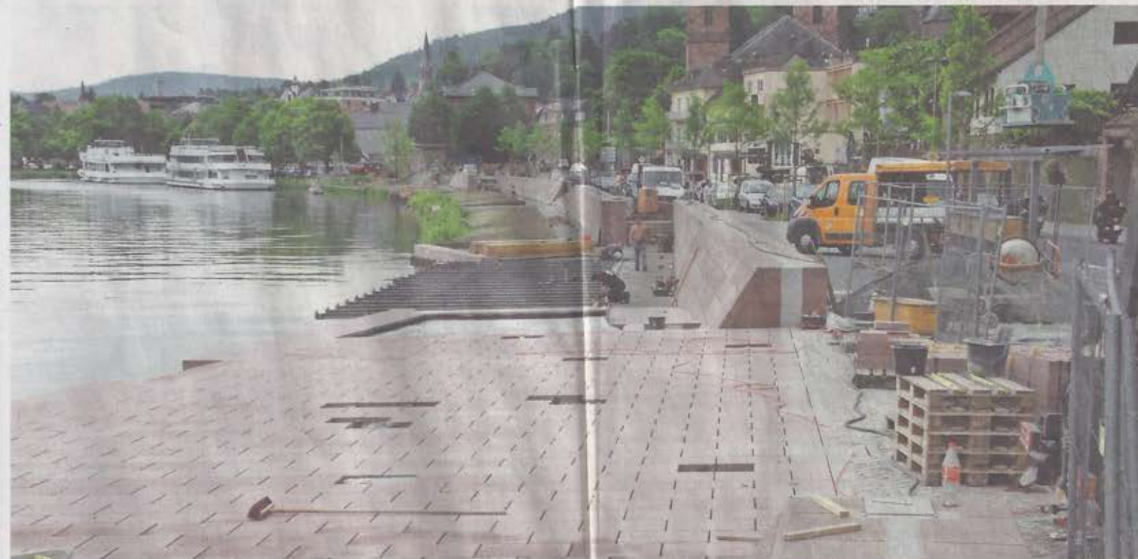
Letzte Arbeiten am Miltenberger Flussforum, dem städtebaulichen Glanzlicht der neuen Mainpromenade. Am 1. Juni wird hier die Hauptbühne des dreitägigen Mainfestes stehen. Fotos: Georg Kümmel
