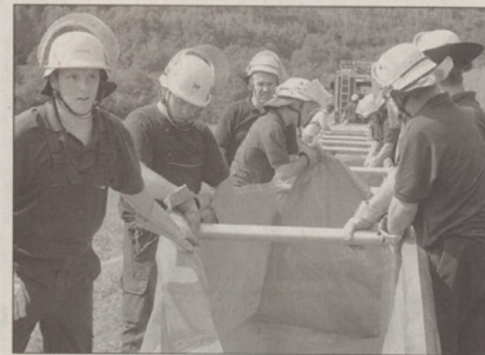
Die Feuerwehr Wächtersbach errichtete einen Quickdamm vor der Staumauer.
